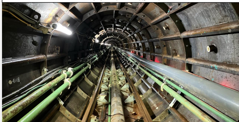
シールドトンネル内部の状況
