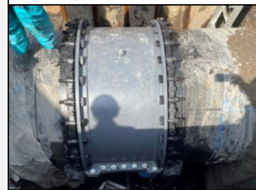
漏水復旧の状況
