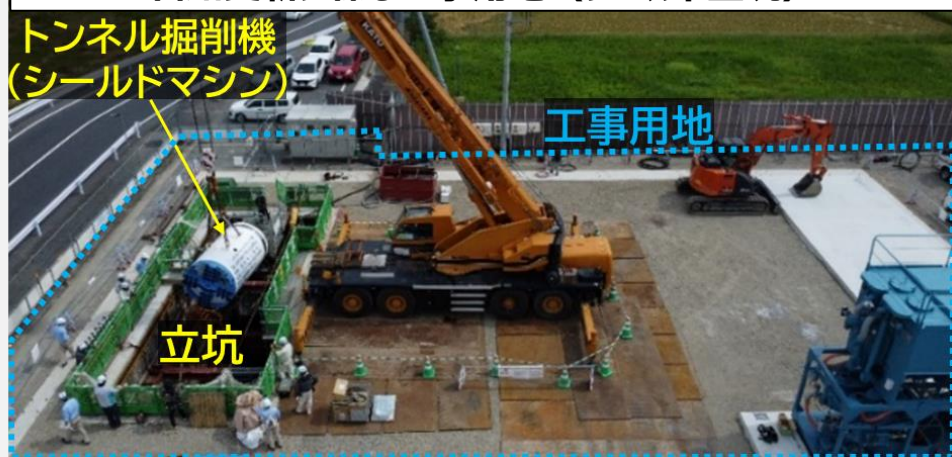
管路更新に係る工事用地（シールド立坑）
