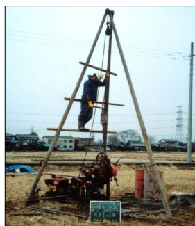
図1 ボーリング調査の様子
