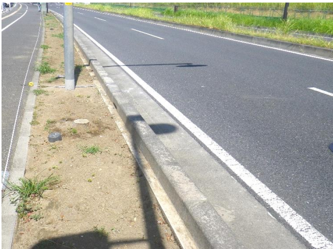
写真1 除草剤の散布により街路樹が枯死したことが疑われる植樹帯。道路の反対側は青々としている。
