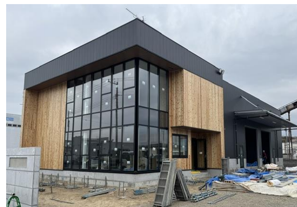
栃木営業所（栃木県）
