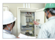
▲電力供給の訓練の様子
