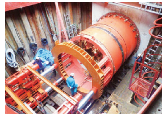
▲下水道管の工事の様子
