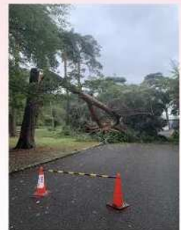
心材腐朽により幹折れしたアカマツ (R7.10月)
