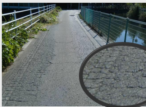
舗装を補修、補強
