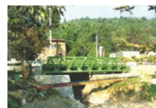
応急復旧 (昭和63年)
