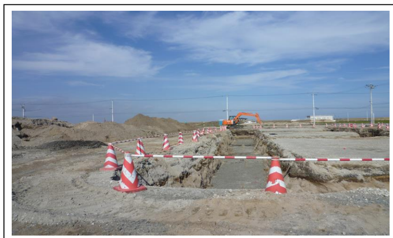
新たに商店街を作る基礎工事を行っている様子
