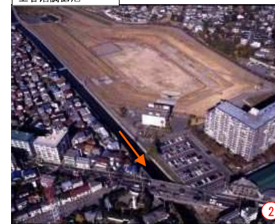
上谷沼調節池
