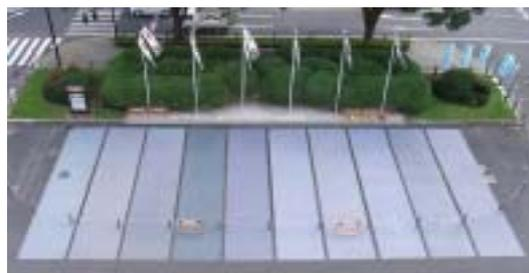
において、遮熱性舗装10技術を施工しました。施工は、既設の透水性アスファルト舗装(劣化はなく均一の仕上げ)の上に遮熱性塗料を塗布しました。
