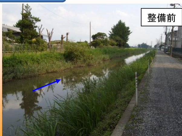
階段がなく川に近づけない (H21.4撮影)
