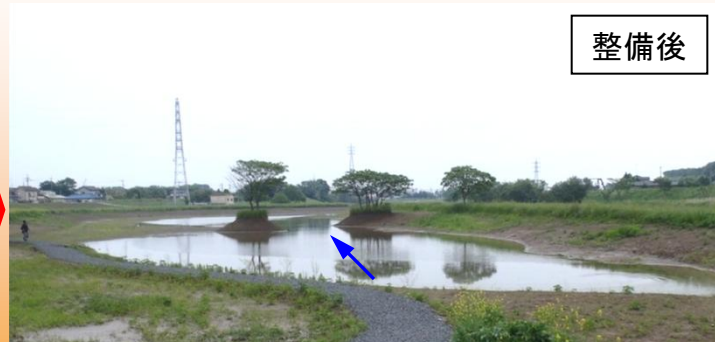
遊歩道や生物のすみかとなるワンドを整備し水辺に親しめるようになった(H23.5撮影)
