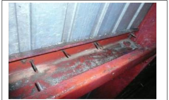
石綿除去細部の状況4
