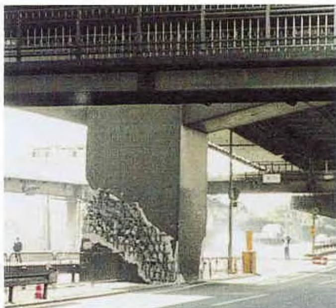
図8.4.3 RC橋脚のせん断破壊による大規模な損傷の例
