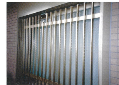
面格子を取り付けた外廊下側の窓
