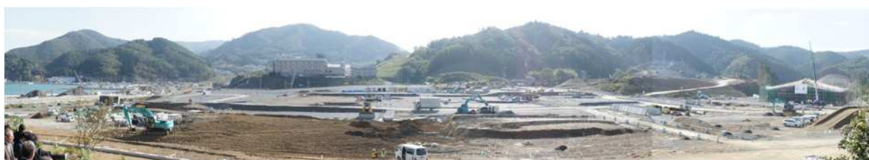
図 1.1.2-5 宮城県女川町の復興状況(地盤の嵩上げ等による現位置復興)
