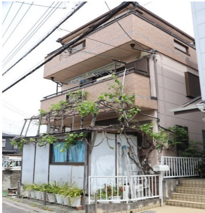
〔写真〕 建物北側から撮影
