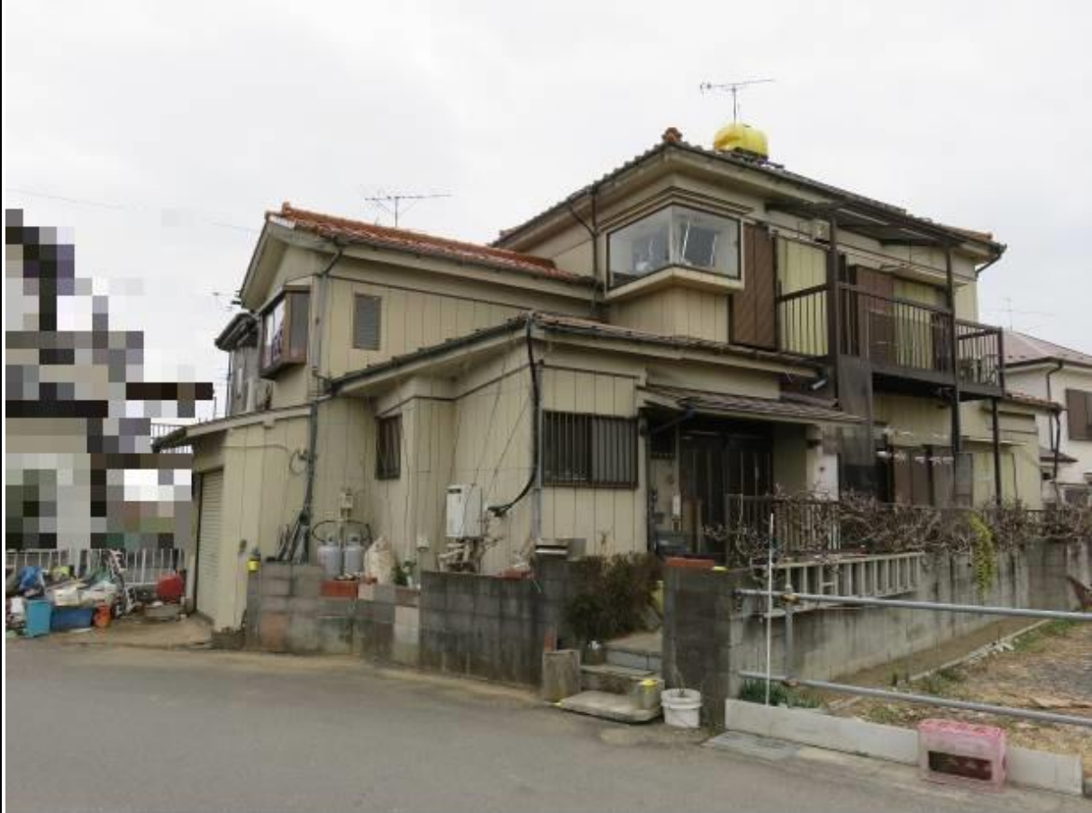
[写真] ※ [建物 西から]
