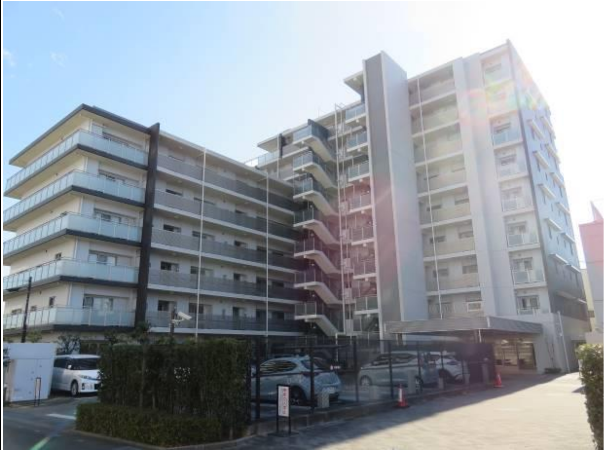
〔写真〕 ※ 〔建物 北西から〕
