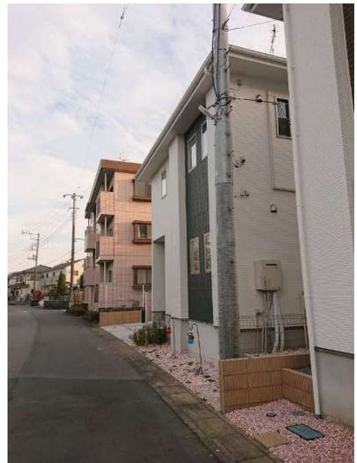
【防犯灯設置事例②】
