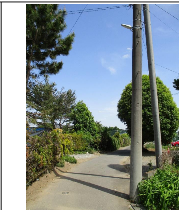
【 防犯灯新設工事② 】
