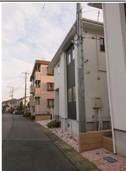
【防犯灯設置事例②】
