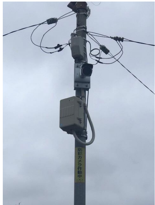
【鷺宮駅西口第一自転車駐車場②】
