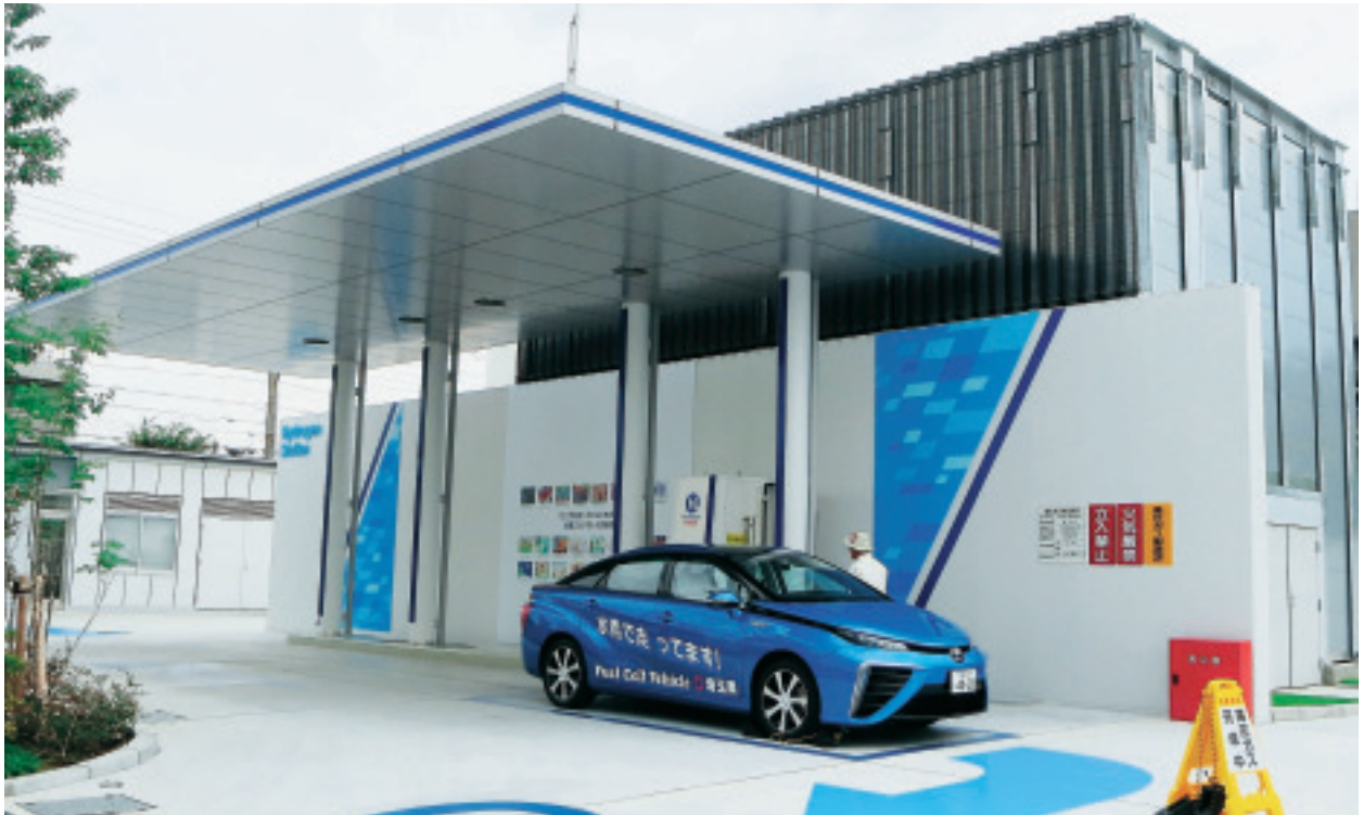
写真3-13-6 水素ステーション(戸田市)と燃料電池自動車
