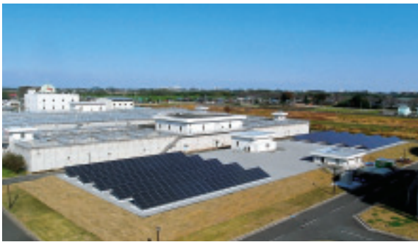
写真3-13-2 県有施設への率先導入（吉見浄水場）
