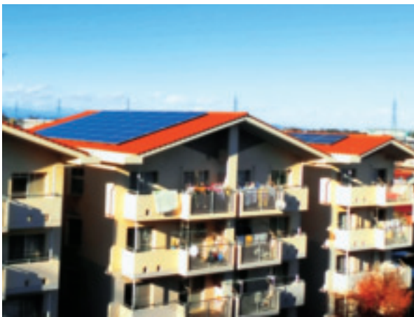
写真3-13-3 屋根貸しによる太陽光発電事業（県営住宅）
