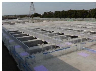
高度処理 (窒素・リンをより多く削減)
