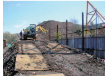
违法抛弃现场的障碍撤除情景
