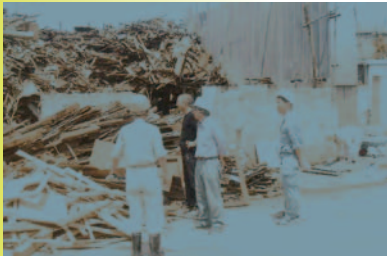
建筑废弃物分选后保管设施的一例
