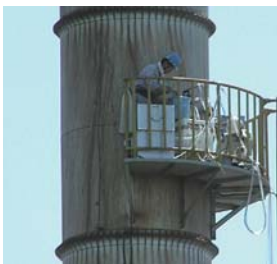
焼却炉排ガスの調査
