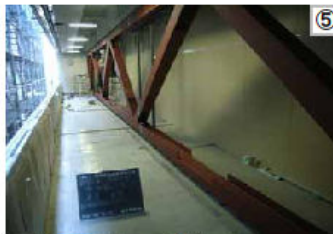
仮間仕切壁 施工完了(執務室側)
