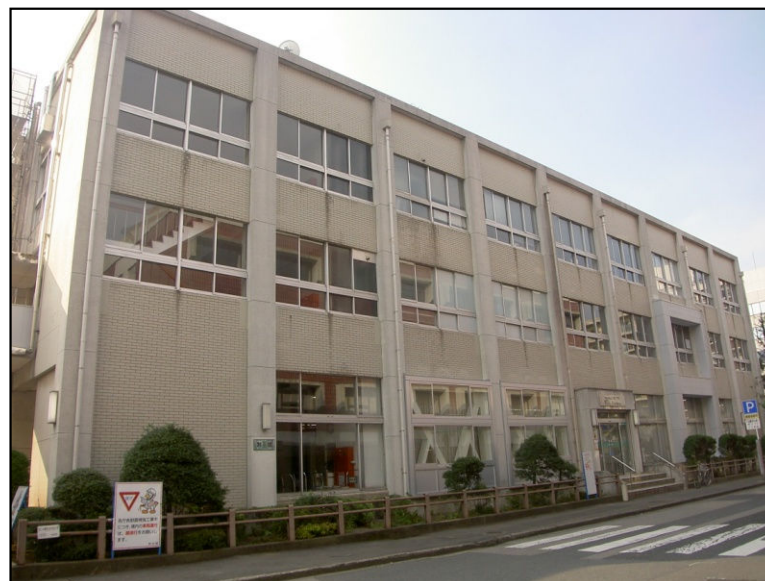
補強 北側 1階 (SBR)
