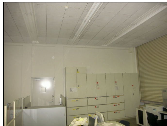
耐震 RC壁新設 (1階)
