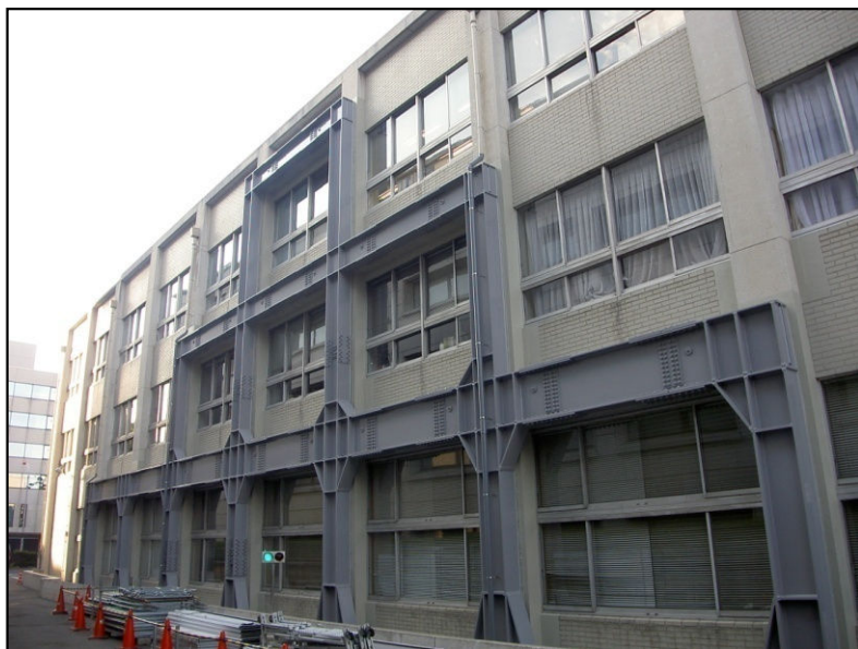
外部 補強 南側 (PG)
