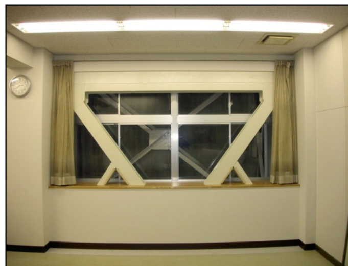
耐震 鉄骨ブレース（地階）
