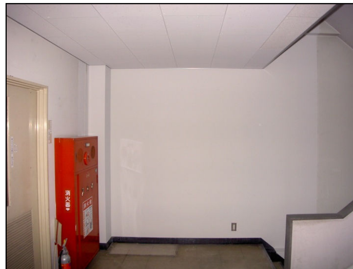
耐震 開口閉塞 (2階窓)
