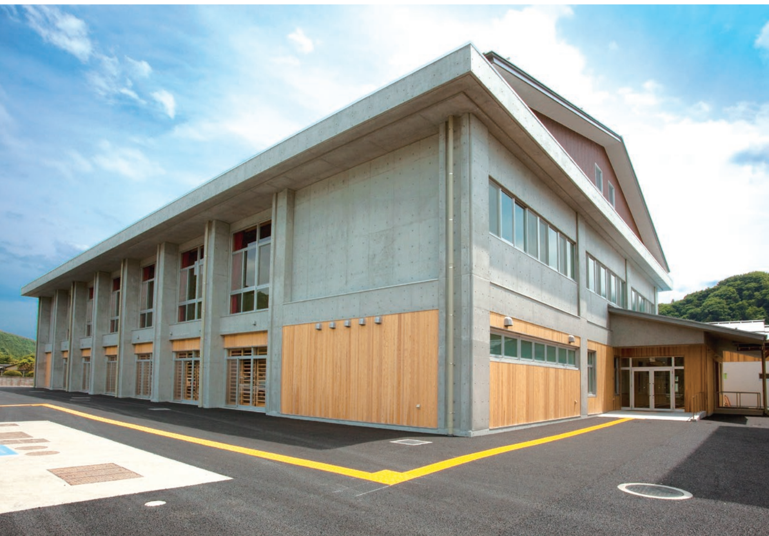
体育館外観 外壁にも埼玉県産木材を使用
