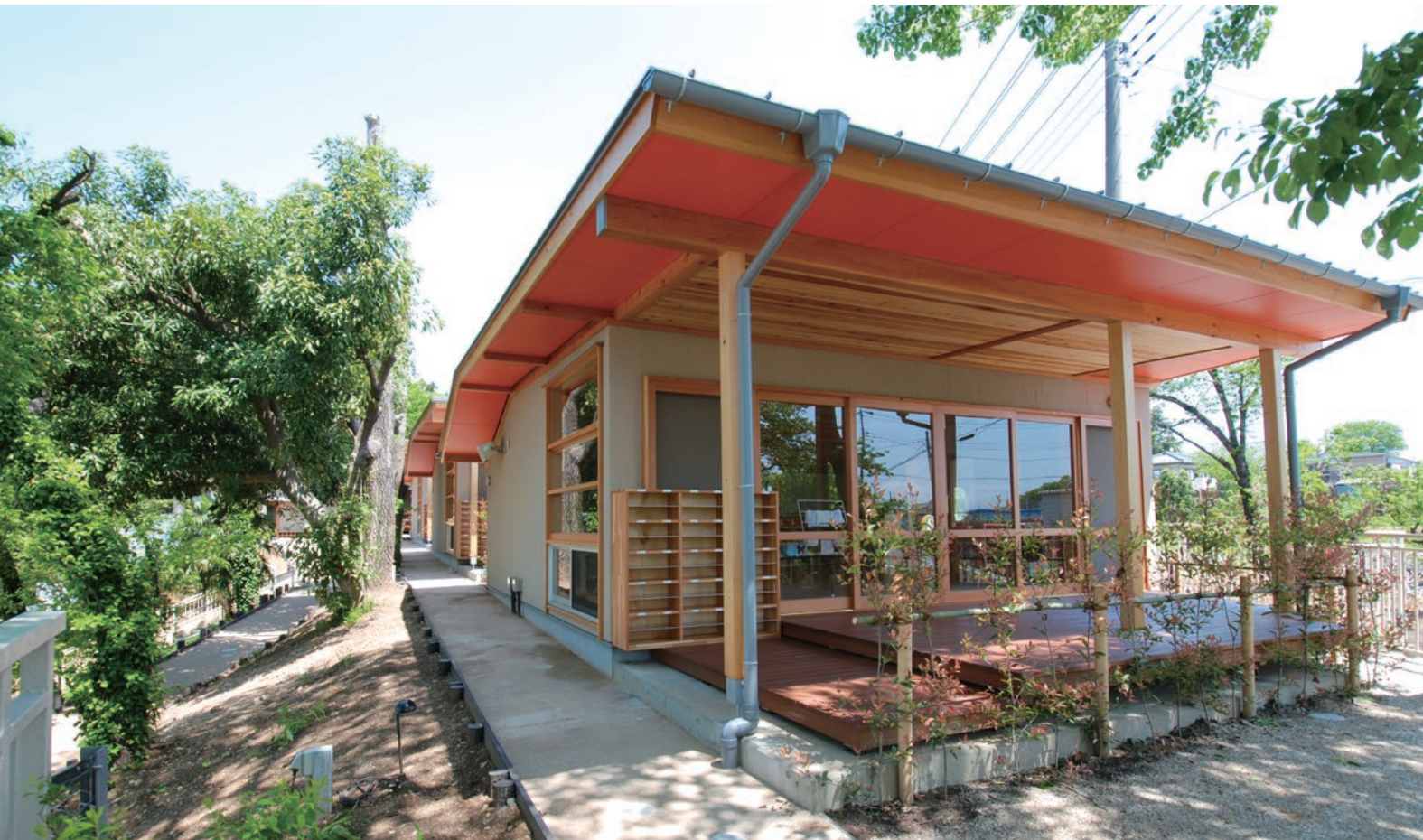
保育室と同レベルで繋がるウッドデッキのテラス 柱・梁あらわし、木製硝子戸
