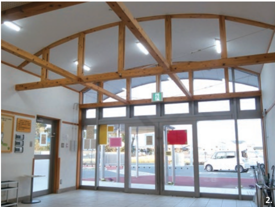
1.重ね梁で大部屋を可能にした多目的ルーム 2.玄関ホールで園児たちを迎えるアーチ形トラス
