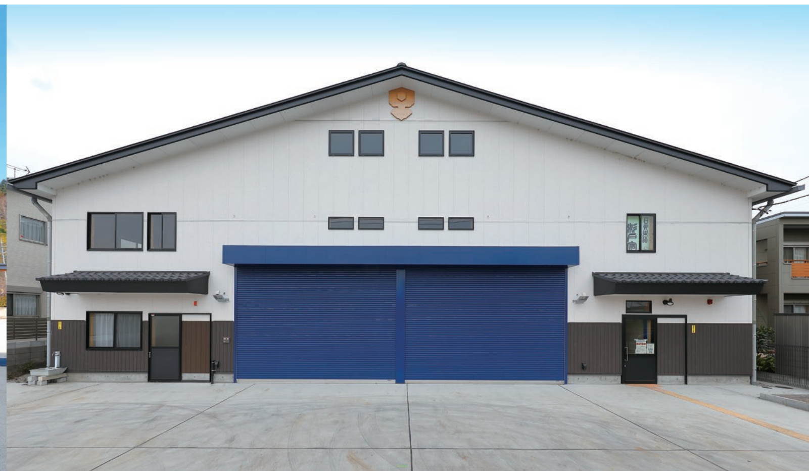
古利根川に面した施設南側外観
