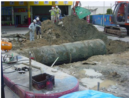
腐食等劣化による事故の例
