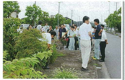
写真1：中央分離帯緑化（川口市 道合の現場）
