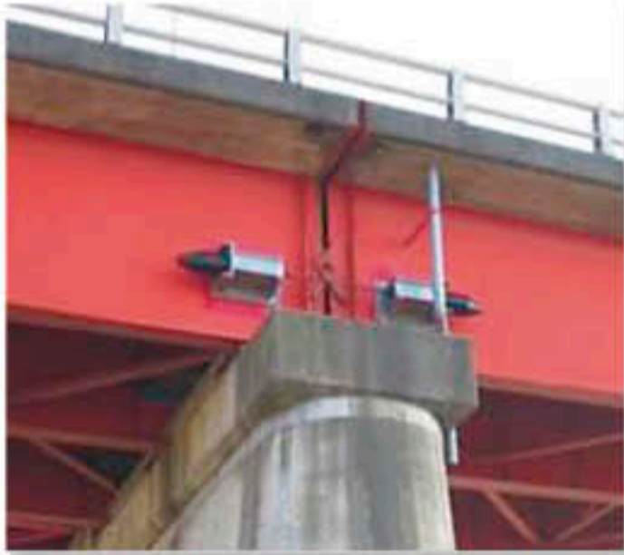
横りょうの耐震補強(落下防止)
