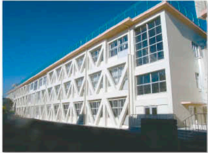
耐震補強後の校舎(狭山市立西中学校)
