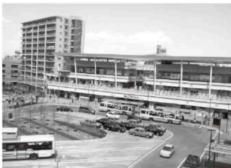
狭山市駅西口地区市街地再開発事業(狭山市)
