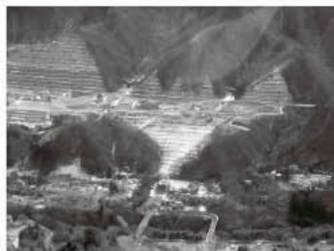
ハツ場ダム工事現場
