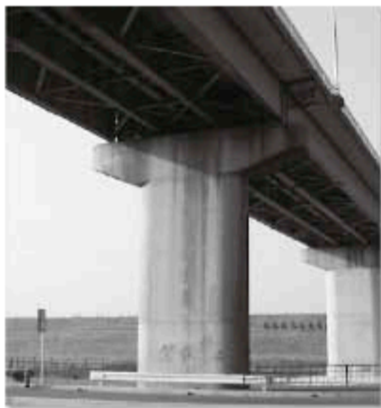
緊急輸送道路に架かる橋りょう(橋脚)の耐震補強
