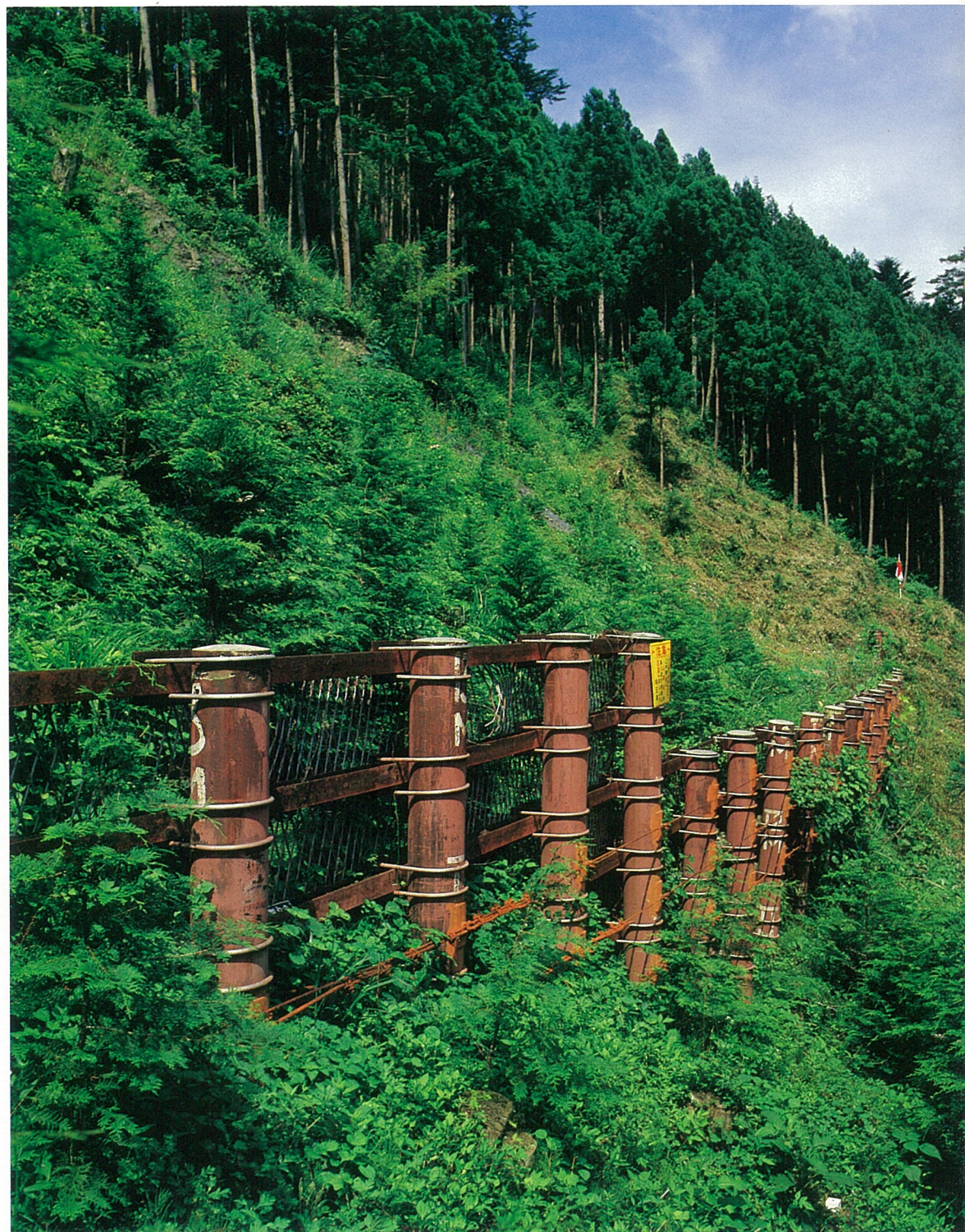
滝の沢 昭和50年度 大滝村大滝 鋼管杭打工
