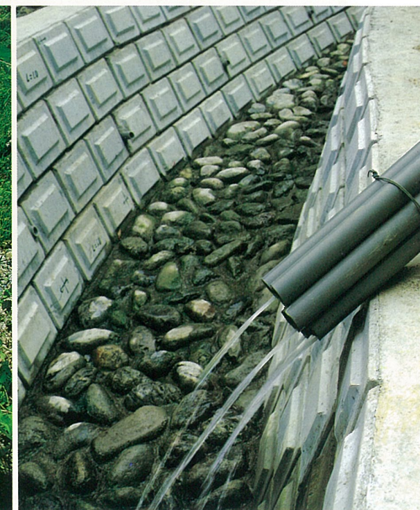
二瀬 昭和55年度 大滝村大滝 ボーリング暗きょ工 水路工
