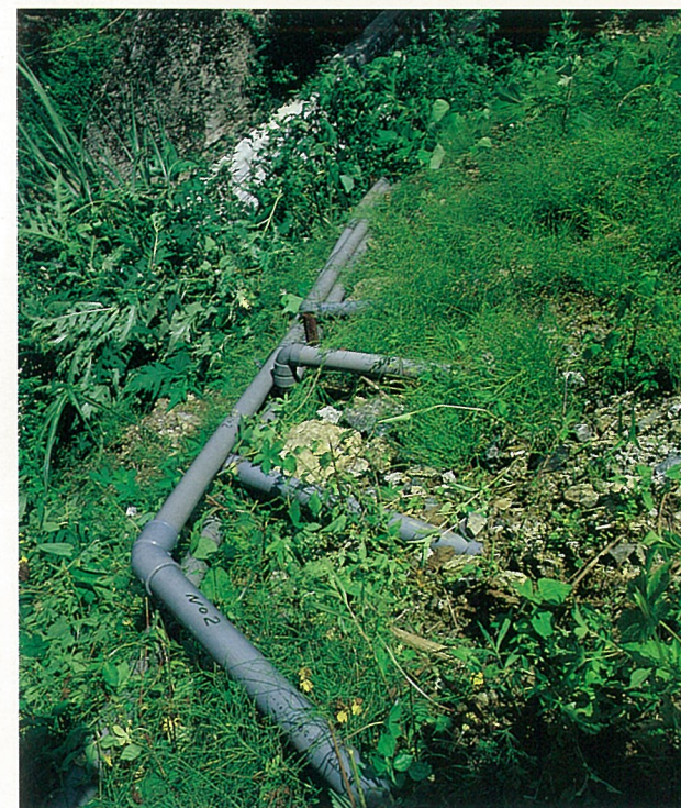
二瀬 昭和55年度 大滝村大滝 ボーリング暗きょ工
