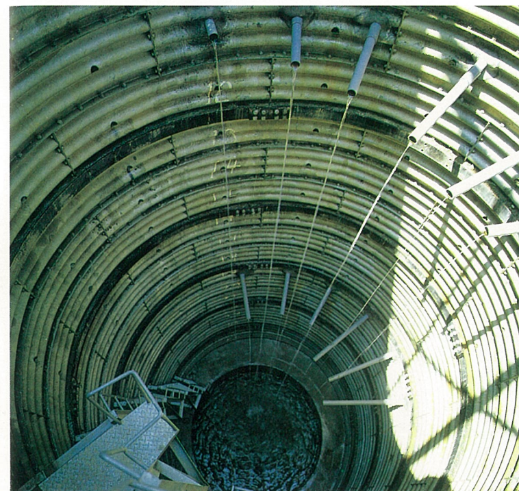
朝日根 昭和55年度 東秩父村皆谷 鋼製集水井工
